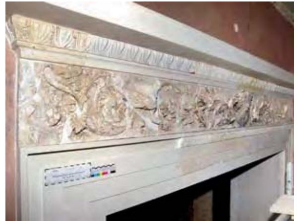
▲ Verdachung Raum 3.02 Verdachung aus Marble-Cement, Ornamentein- lagen Gips
