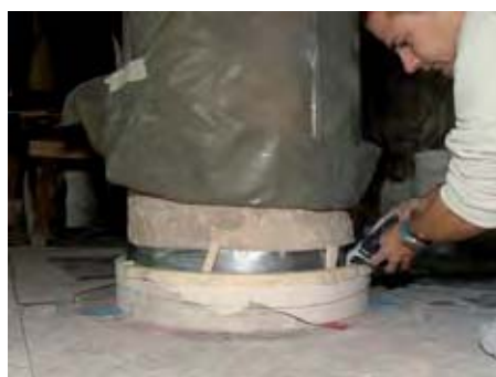
◀ Vergießen der eingerichteten Basis
