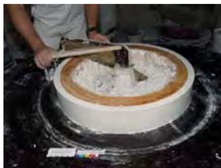
◀ Drehen der Basis als Ring mittels einer Radius-schablone
