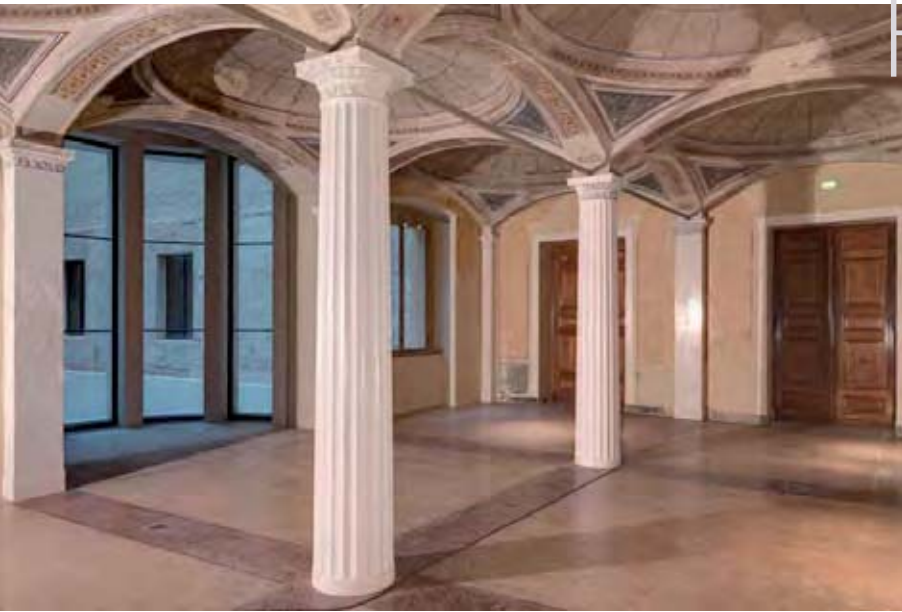
◀ Flachkuppelsaal Raum 1.04 Säulen aus Marble-Cement im Flachkuppelsaal
