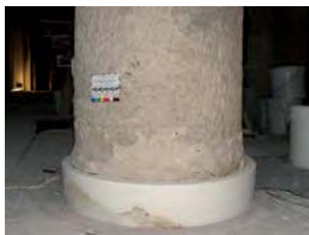
◀ Fertige angearbeitete Säulenbasis
