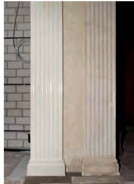
▲ Doppelpilaster aus Marble-Cement. Der linke Pilaster ist neu.
