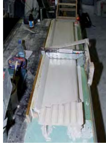
▲ Herstellung eines Pilasters als Tischzug. Im Bildvordergrund ein abgeformtes Originalteil in Gips ausgegossen. Gegen die Bruchkante wird gezogen. Nach dem Aushärten des gezogenen Pilasters wird der Gipsausguss entfernt, und der neue Marble-Cement-Pilaster kann später wie ein Inlet in die Altsubstanz eingefügt werden.
