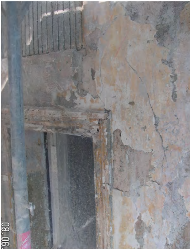
nach der Freilegung sichtbare Spachtelmassen
