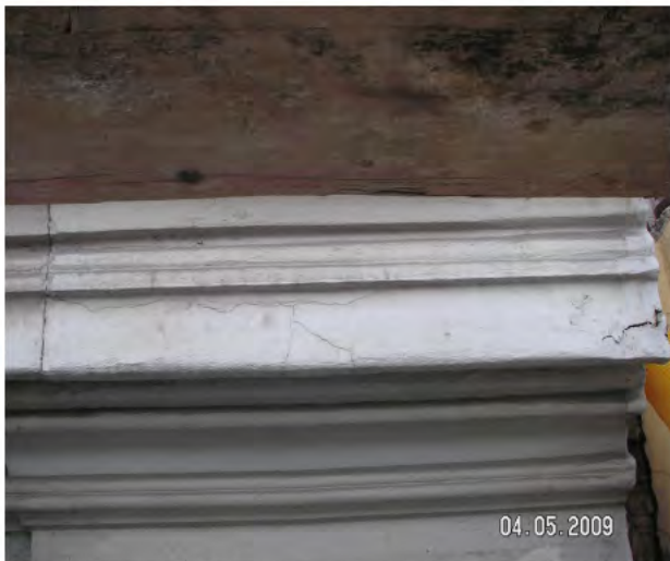
unsachgemäße Zement“Ausbesserungen“
