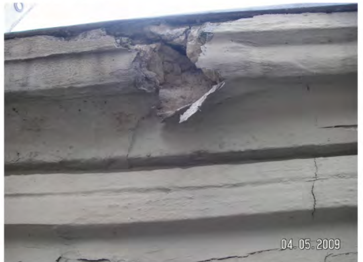
unsachgemäße Zement“Ausbesserungen“
