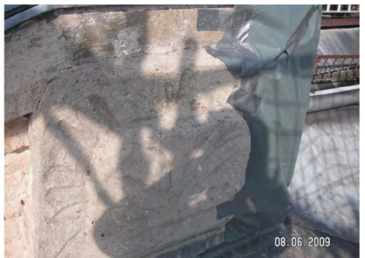
Modellierung aus den „80-zigern“ verblieb als Zeitzeuge, da im Stück ohne schädigende Wirkung
