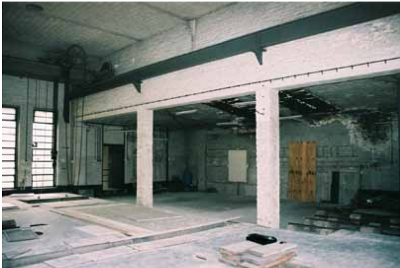
Das 1. Obergeschoss vor dem Umbau
